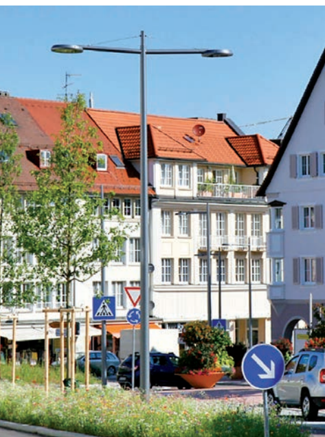
Im Mittelstreifen werden zweiarmlige LED-Leuchten eingebaut, die über eine intelligente Technik verfügen (Foto: Hersteller WE-EFI).
